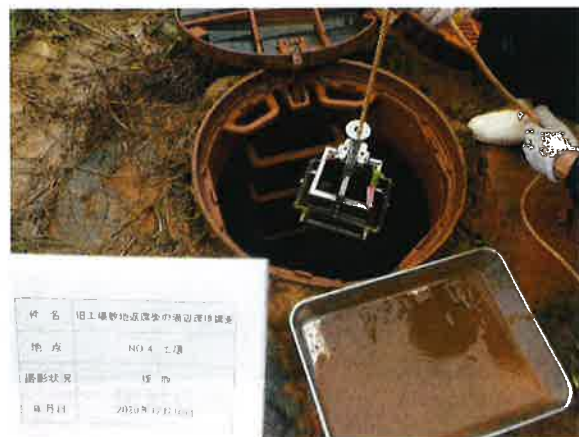
NO 4 採土状況
