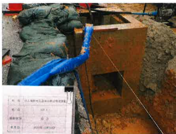
NO 3 地点状況
