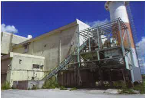
第3工場解体工事着手前(平成26年9月撮影)
