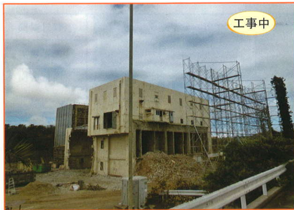
旧第2工場解体工事進捗状況(東側より撮影)平成26年2月
