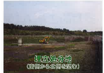
埋立処分地 (南側から北側を望む)
